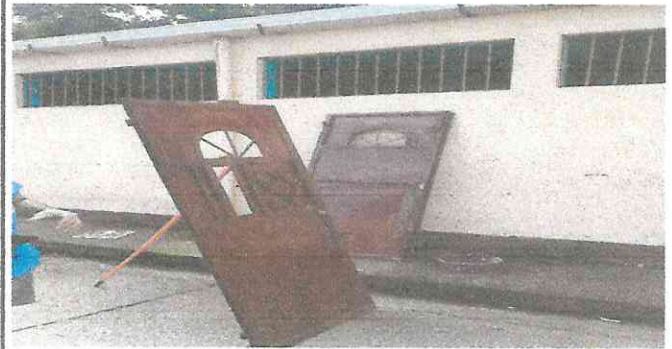
Foto 2: pintura de puerta
