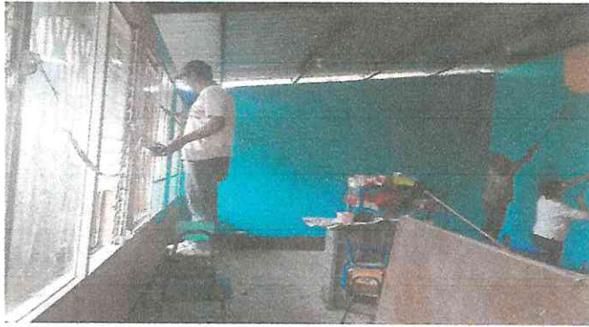
Foto1: pitando paredes y quitando las ventanas del aula
