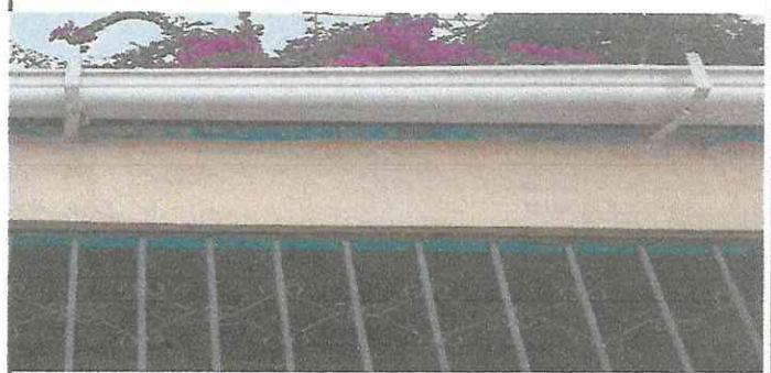
Foto 6: cambio de canal y bajadas de agua
